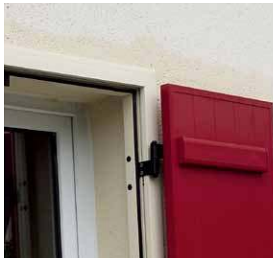
PRÉCADRE EN ALUMINIUM pour une occultation et finition parfaite.
